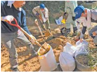
土のう袋にスコップで土砂を詰め運び出す作業は、かなりの重労働にも関わらず、お昼を挟んで丸一日続きました。
